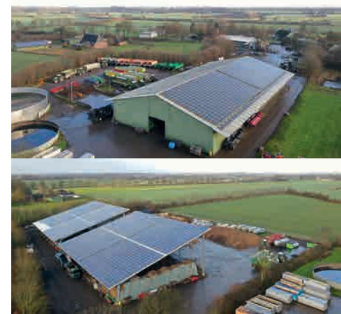
Photovoltaik: Halle und Pultdach in Rendswühren
