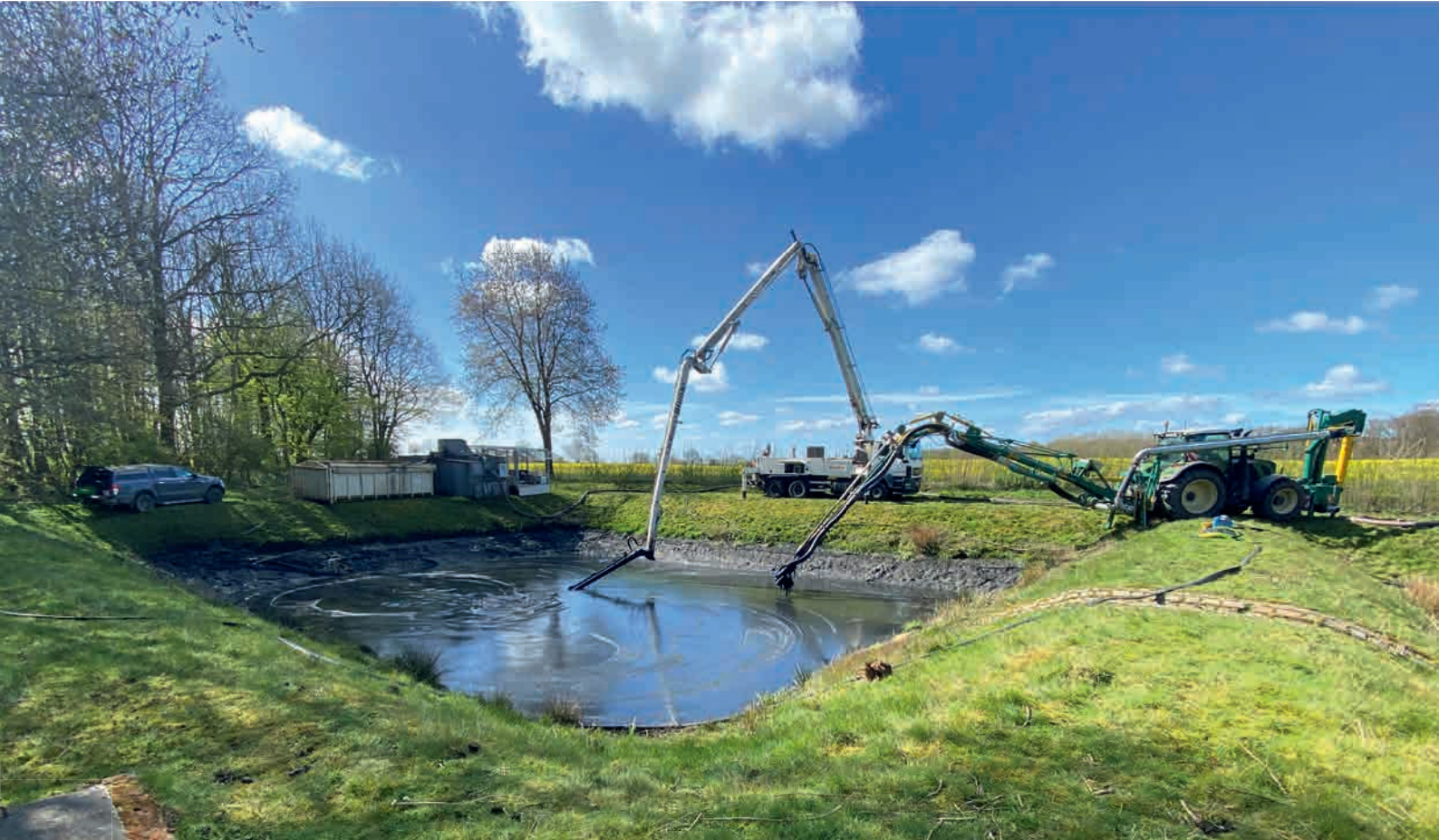
auführen in Behältern XXL
